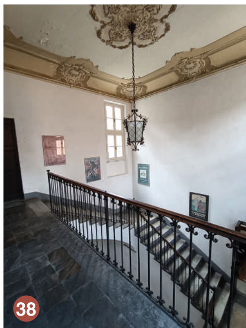
Fig. 36 Particolare di scala a sbalzo
